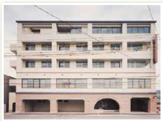
開院時の病院 病院らしくない病院づくり
